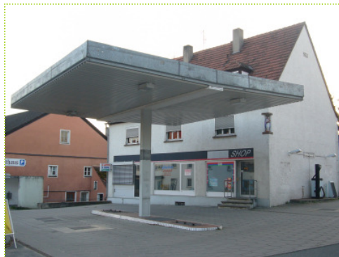
Verlassene Tankstelle in Röttenbach bei Roth
